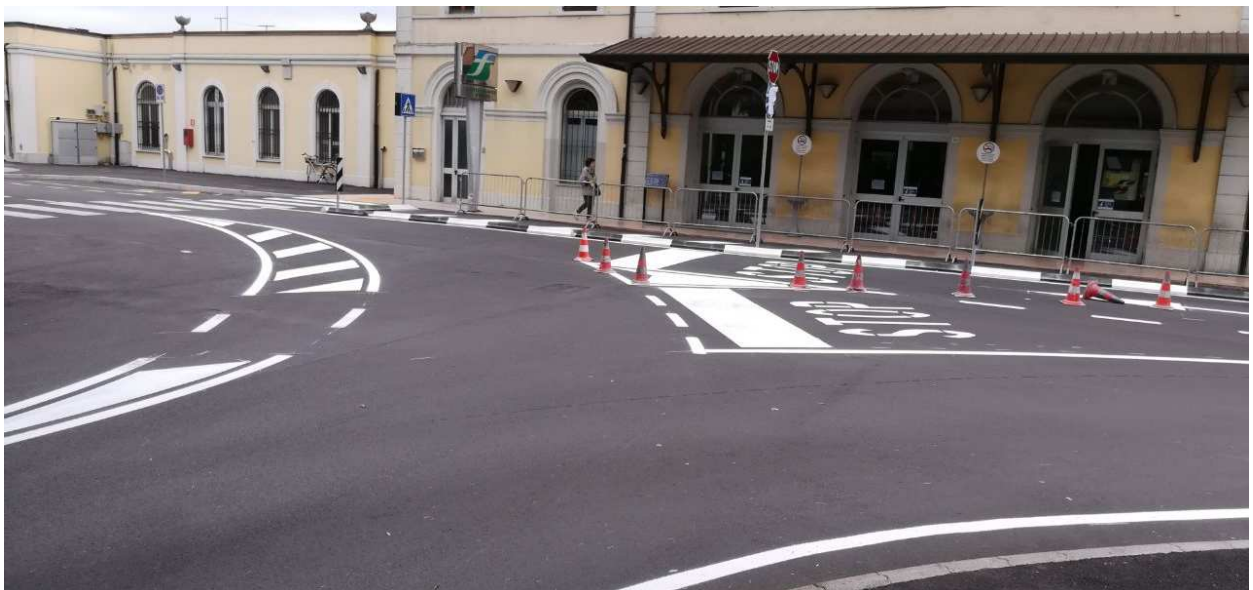
Figura 8.2 – Intervento realizzato – vista da Viale Brigata Battisti
