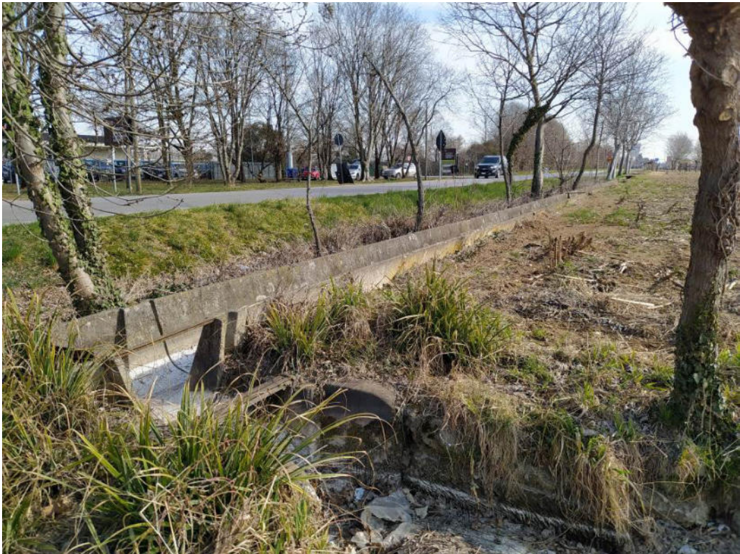
Foto 5 - immette della canaletta sul fossato consortile che prosegue verso sud
