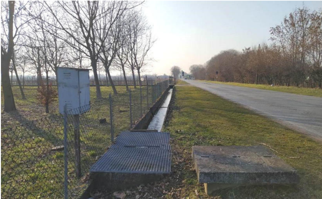
Foto 3 - incrocio tra S.P.102 e via Baciocchi: manufatto partitore esistente. Sulla destra è presente un pozzetto di sfiato dell’acquedotto
