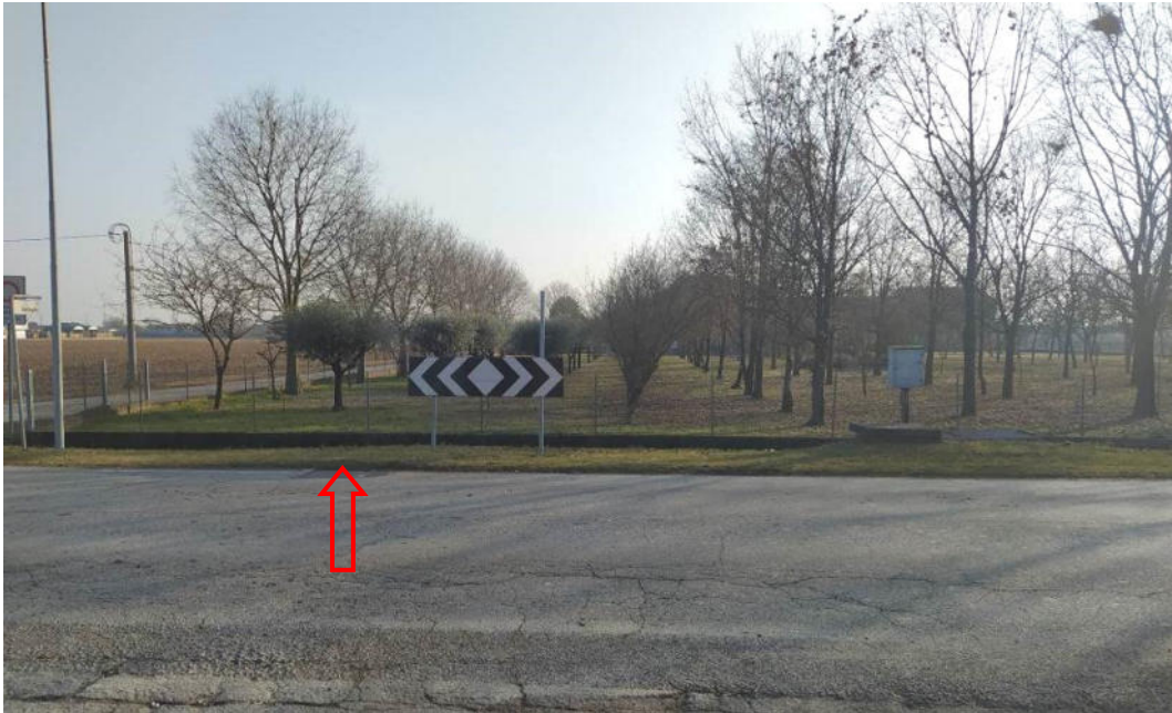
Foto 6 - SP102 presso l'incrocio con via Baciocchi. La freccia indica il pozzetto corrispondente al nodo C
