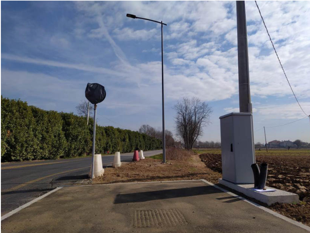
Foto 1 - Inizio pista ciclopedonale presso rotatoria via Loreggia di Salvarosa: vista verso est
