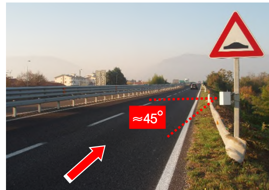
Figura 5.2 – Angolo di installazione dei radar rispetto alla direzione di marcia
