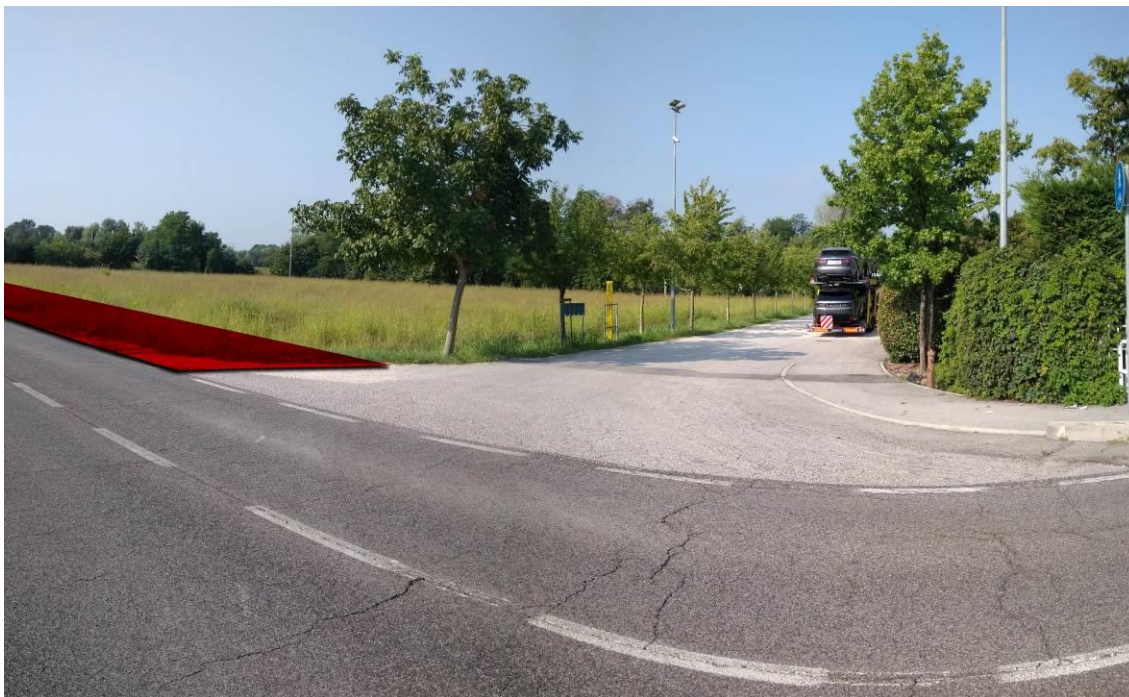
Tratto nord tra la pista ciclabile esistente ed in rosso quella da realizzare
