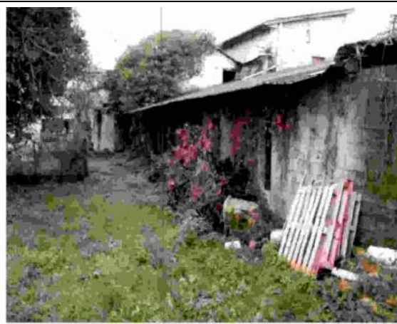
FOTO 7 – VISTA DA OVEST DEL PROSPETTO NORD
