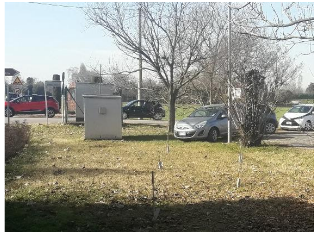
Figura 5 - Gruppo di Riduzione e Misura (GRM)
